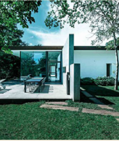
Cabaña en el Río - arquitectos Robby Cantarutti y Francesca Petricich
